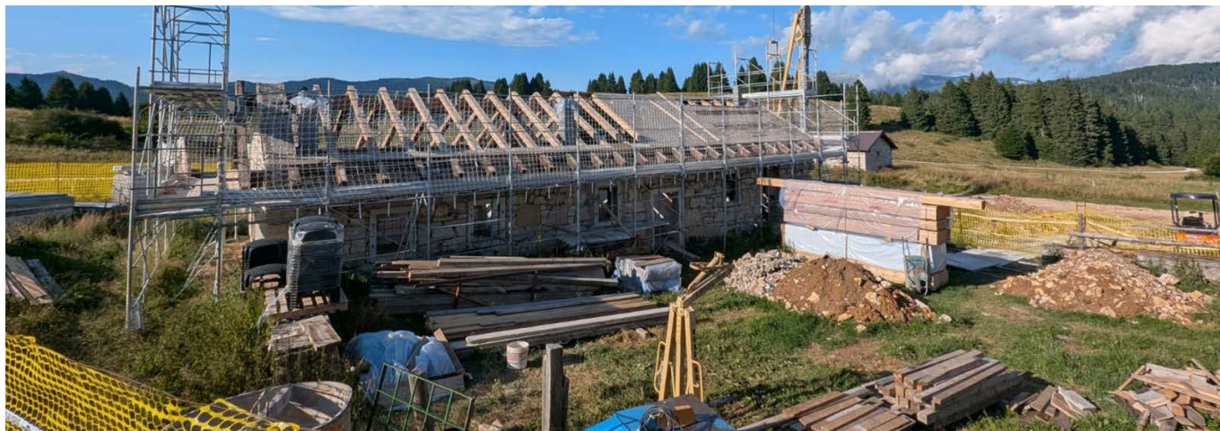
Lavori a Malga Costesin
