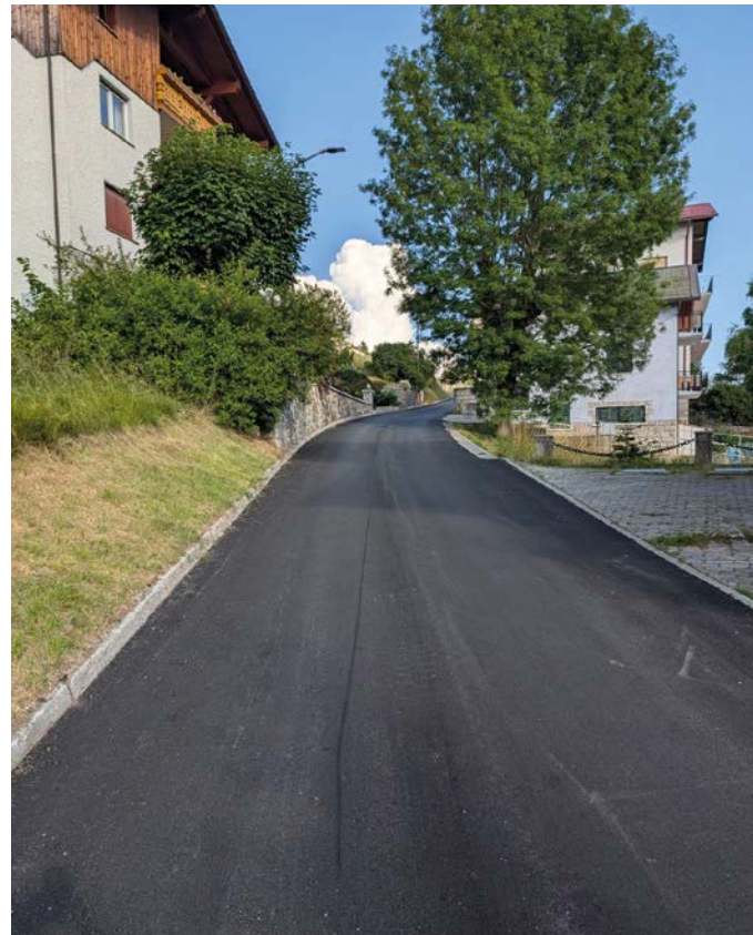
Asfaltatura, Via Tezze
