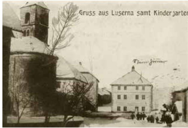
Di kirch, di kanònega, da taütsch schual un dar tiafprunn
